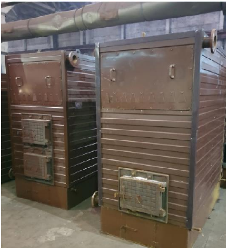
Котел водогрейный ручной (КВР)
